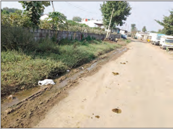
బోర్లకుంట గ్రామపంచాయతీ లోని రాళ్లగూడ గ్రామంలో డ్రైనేజి కాలువ లేక రోడ్డుపై మురుగునీరు
